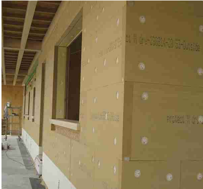
La Fibra di legno in pannelli per il cappotto esterno e per la stratigrafia del Tetto
