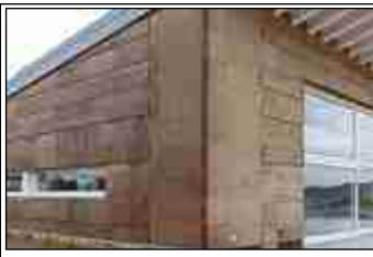
Il sughero da facciata: in pannelli per cappotto, in granuli per riempimento, in lastre sottopavimento
