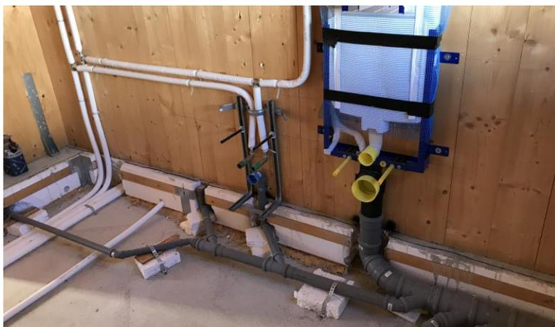
Le risalite degli impianti si possono ricavare nello spessore della parete del cassero limitando al minimo o eliminando completamente le rotture del cordolo in calcestruzzo.
