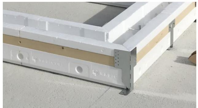
Riempire l'interstizio tra il cassero e la fondazione utilizzando schiuma poliuretanic per il fissaggio definitivo e per impedire la fuoriuscita di calcestruzzo. Completato il fissaggio eseguire gli spazi soglia (vedi "DETTAGLIO IN CORRISPONDENZA DELLE SOGLIE DI PORTE E BALCONI") e la posa dei connettori cordolo-fondazione e delle staffe premontabili Radicsol (se previste).
