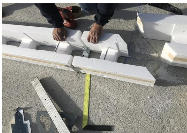
Registrare le staffe con l'ausilio della livella laser utilizzando le viti di registrazione poste sulla staffa Radicsol che permettono di regolare sia l'altezza che l'inclinazione
