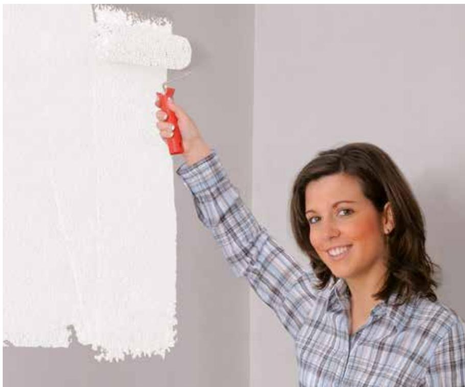
L'intonaco a rullo **fermacell** può essere pigmentato con idropitture, pitture in lattice, acriliche e a resina siliconica.
