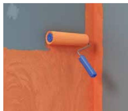
Applicare su tutta la superficie due strati della guaina liquida sigillante **fermacell** con il rullo (spessore complessivo  $\geq 0,5$  mm); tempo di asciugatura per entrambi gli strati: almeno 2 ore
