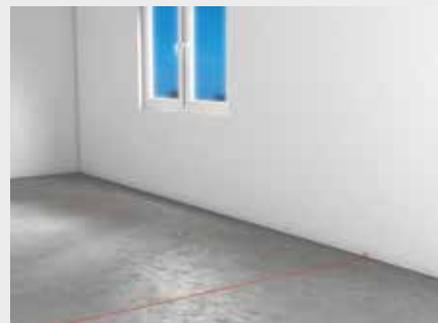
Definizione dell'asse di allineamento della parete con battifilo o tracciatore laser per edilizia
