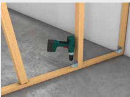
Montaggio delle sottostrutture di legno con chiodi senza testa o angolari in acciaio
