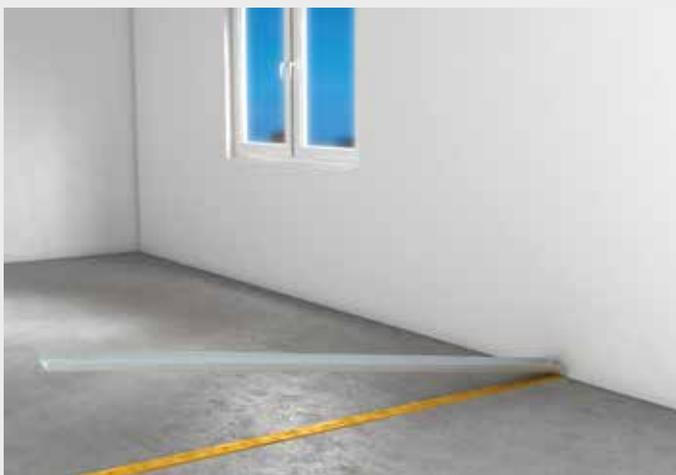
Posa delle guide a U sul pavimento su strisce perimetrali isolanti
