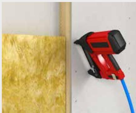
Tamponamento della sottostruttura in legno con graffe
