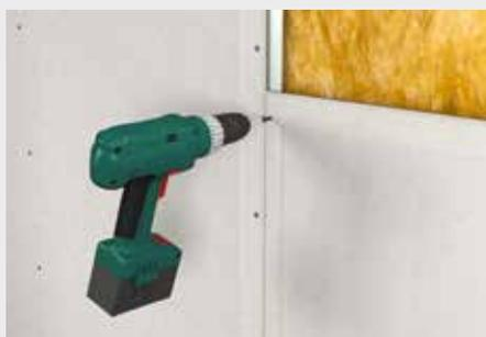
Viti su sottostruttura di metallo
