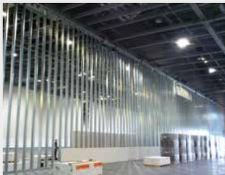
Nonostante altezze di montaggio di quasi 10 m e un ridotto spessore della sezione, le pareti fermacell mantengono elevati standard di sicurezza statica
