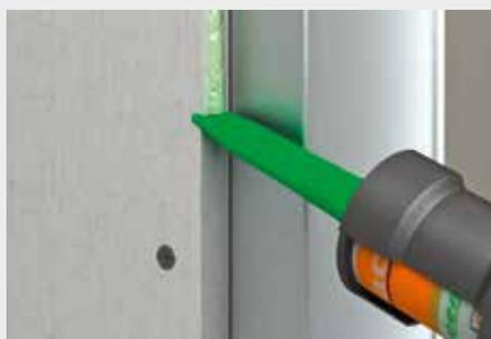
Applicazione facilitata della cartuccia da 310 ml lungo il bordo della lastra. Grazie allo speciale beccuccio, viene erogata la quantità esatta per lastre da 10 e 12,5 mm. Per le lastre da 15 e 18 mm la punta deve essere tagliata per una maggiore erogazione
