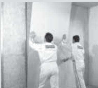
**Tamponamento della sottostruttura metallica**
