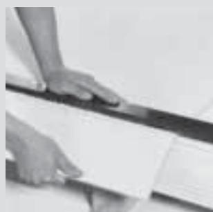
**c. Rottura lungo la linea di incisione**
