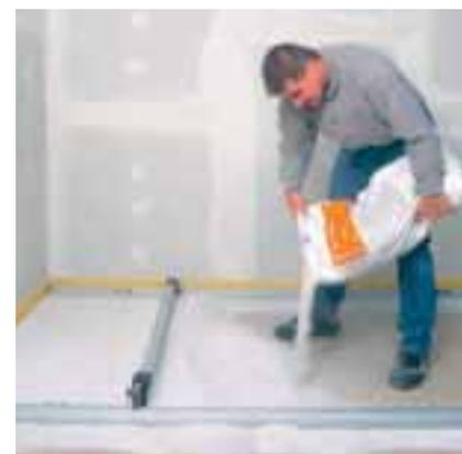
Fig. 3 – Riempimento con il livellante granulare
