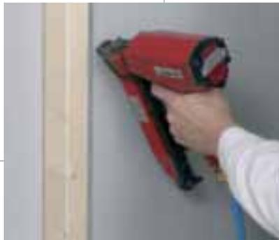
Fissare con graffe o viti alla sottostruttura
