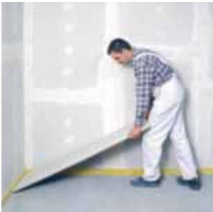
Posa delle lastre per sottofondo FERMACELL
