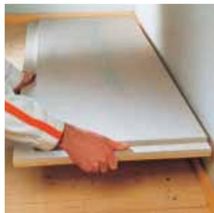
**Posare le lastre per sottofondo FERMACELL**
