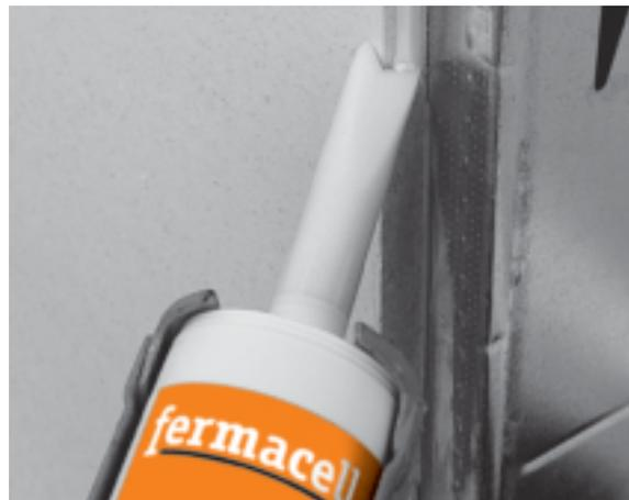
**Applicazione facilitata della cartuccia da 310 ml lungo il bordo verticale della lastra grazie allo speciale beccuccio. Viene erogata la quantità esatta per lastre da 10 e 12,5 mm. Per le lastre da 15 e 18 mm la punta deve essere tagliata per una maggiore erogazione.**
