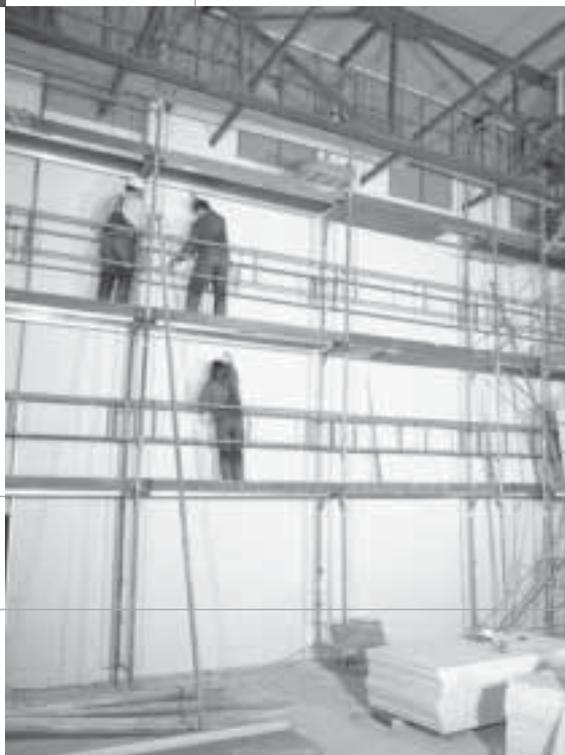
Nonostante altezze di montaggio di quasi 10 m e un ridotto spessore della costruzione, le pareti FERMACELL rispettano elevate esigenze statiche e sono particolarmente solide e stabili
