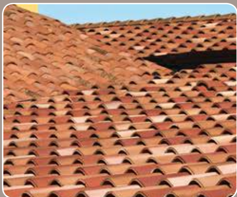
Esempio di integrazione tra nuova realizzazione con Coppo del Borgo e tetto preesistente in coppi tradizionali.
