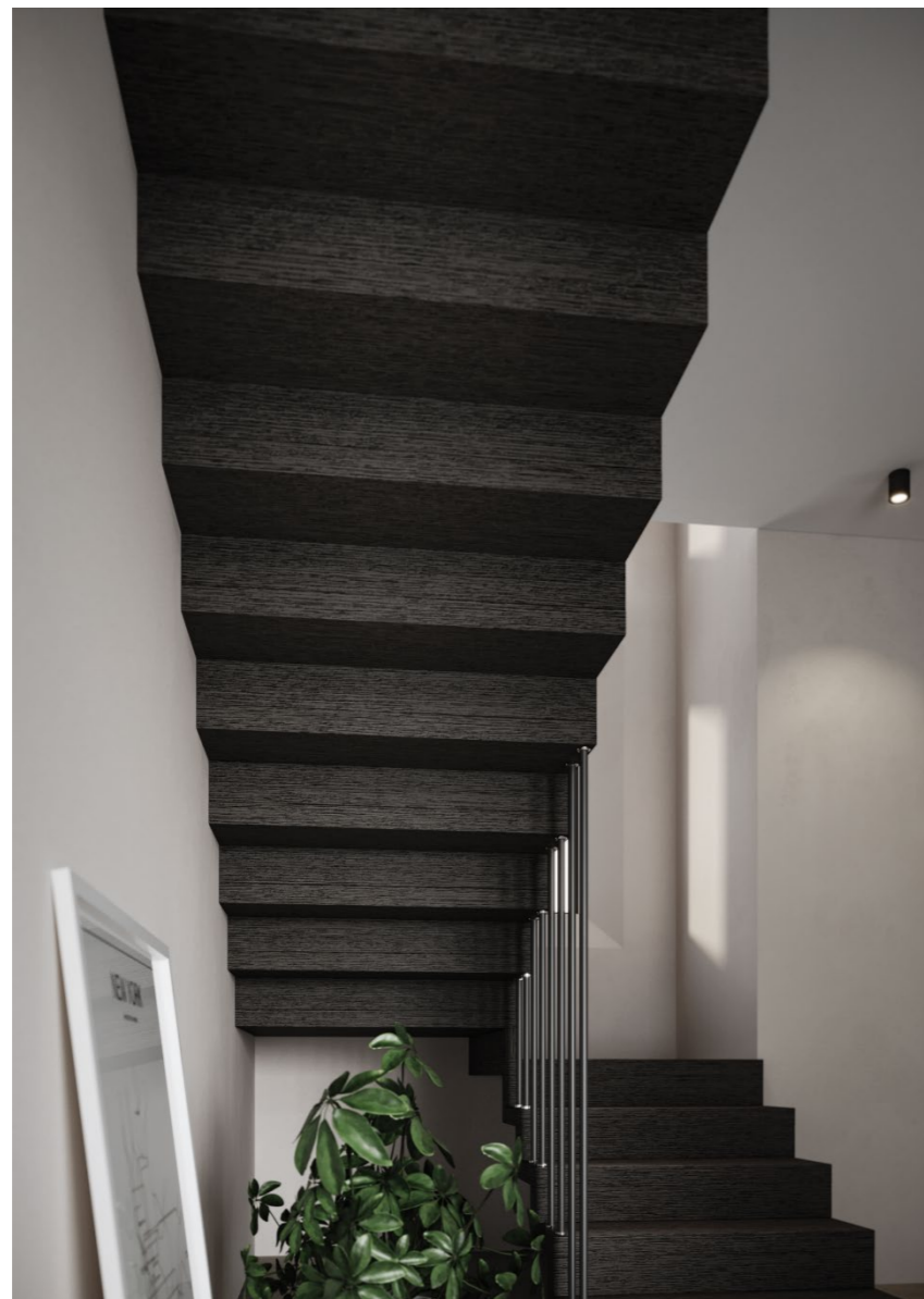
Particolare del sotto scala e ringhiera UP-T che unisce le 2 rampe contrapposte.
