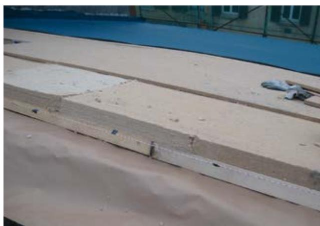
Inserimento di listone interposto al primo strato per il fissaggio della ventilazione su strutture difficili (tavelle in cotto, solai misti, ristrutturazioni)
