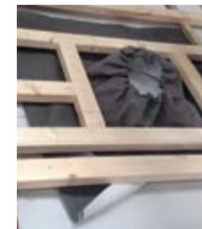
Il nuovo BFX per il tunnel solare grazie all'apertura elasticizzata, impedisce all'umidità di raggiungere il tunnel.
