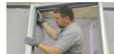
Con l'esclusiva cornice isolante BDX, predisporre il foro sul tetto è facile e veloce. Inoltre la cornice isola il perimetro della finestra a livello termico e acustico, riducendo i ponti termici e migliorando il comfort negli ambienti.
